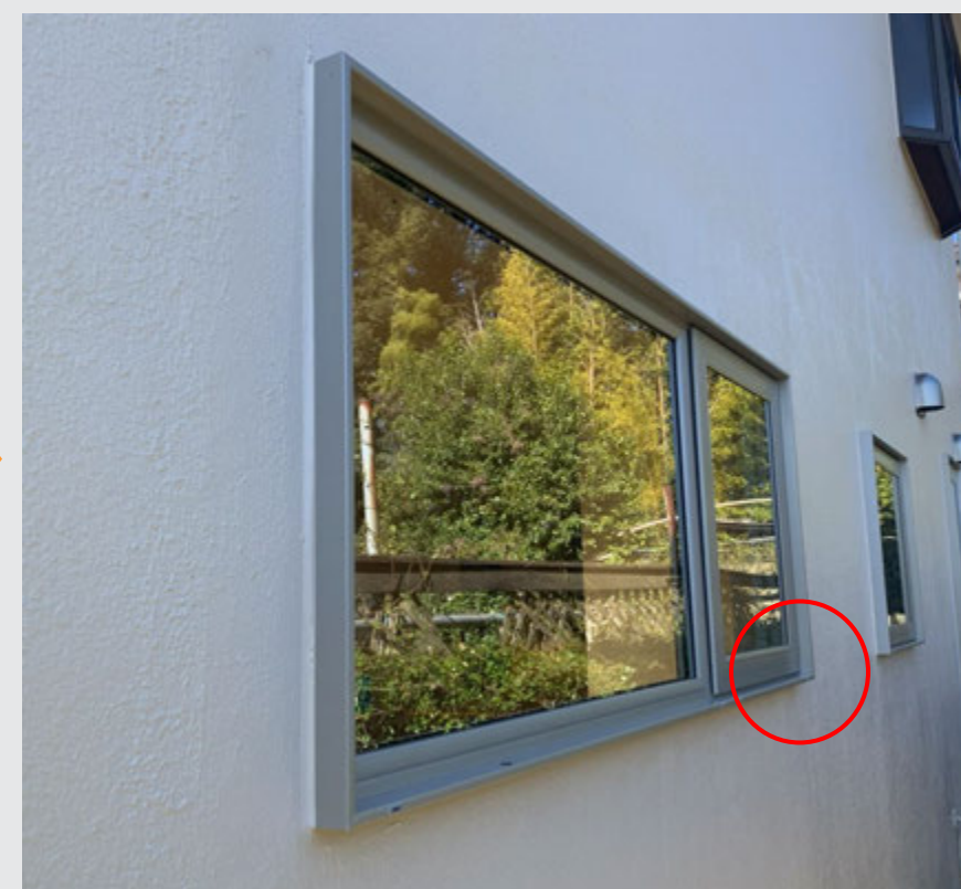
改修時…出窓を高断熱窓に交換し、防水を補修して外壁を塗り直し
