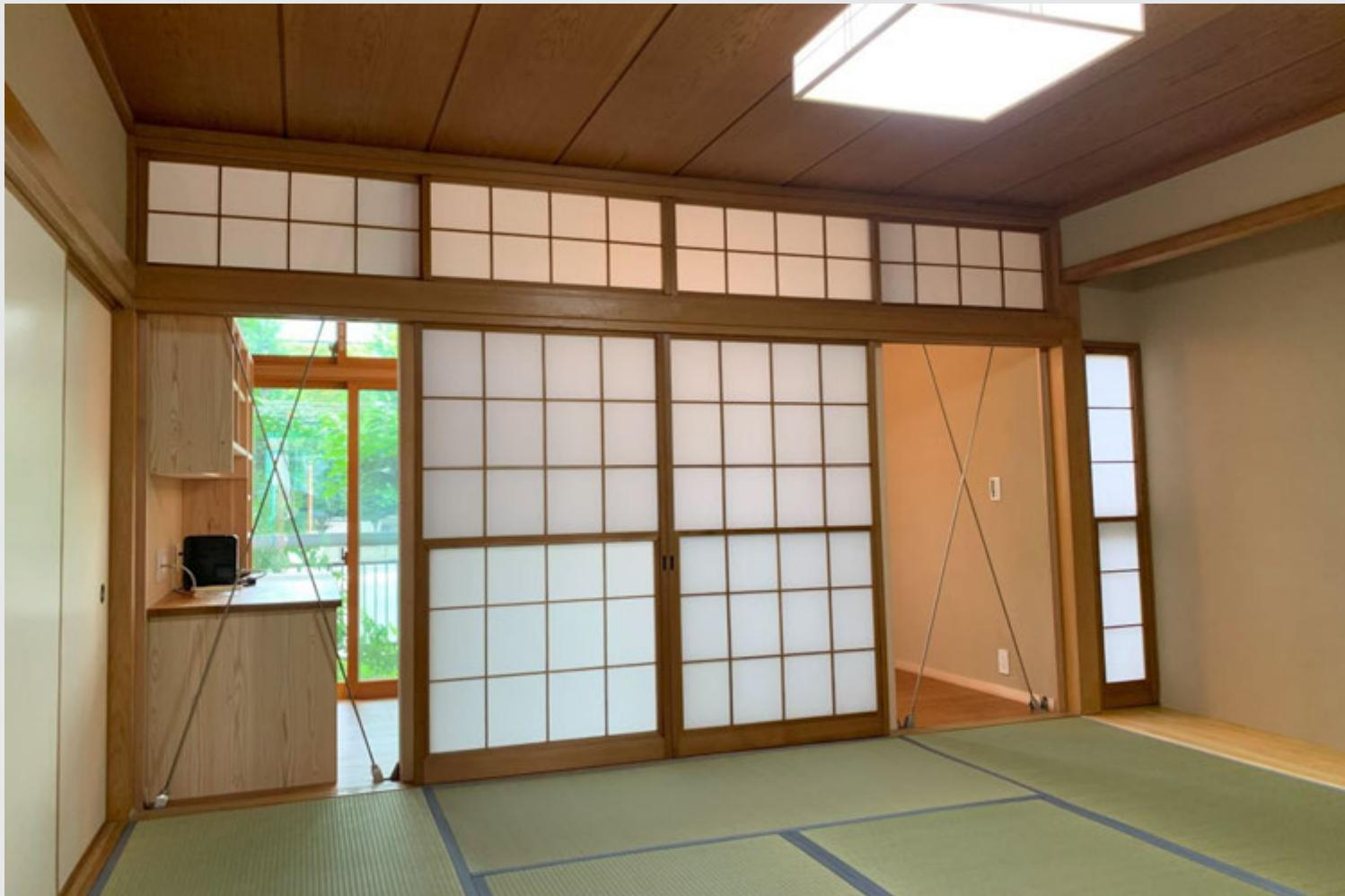
元の和室の雰囲気をそのままに耐震補強／ステンレス筋交いを用いたことで、開放感を妨げない（写真は両端の障子を内側へ引いた状態）
